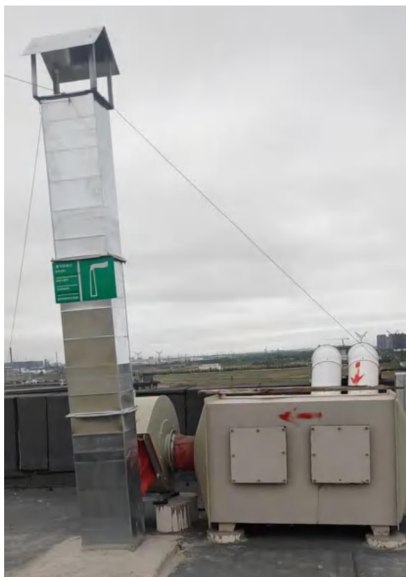
排气筒 DA001：采样孔、采样平台及废气标识牌
